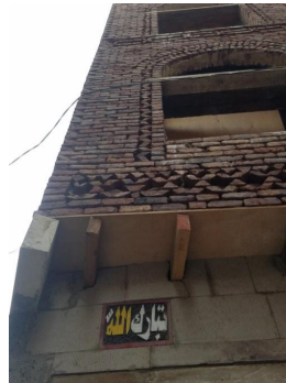
شكل (11)، ظهور تشققات في الجدران البنائية الحجرية نتيجة عدم وضع طبقة المرايبع الخشبية تحت الجذوع الخشبية الحاملة للجدران المعلقة والمنبئية بالباجور (الأجر)
