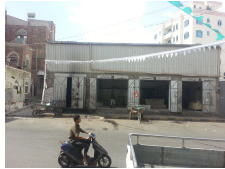
شكل رقم (28): صورة لمنطقة من الشارع وتظهر فية محطة تنقية مياه - معمل صغير - وبدون اي خدمات للمواقف والشحن والتفريغ
