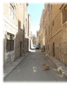
شكل رقم (34): عدم تجانس الواجهات وتشوة الابواب والنوافذ (C6)
