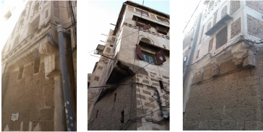
شكل (9): طريقة تعليق الجدران الحاملة من جهة واحدة للحصول على فراغات مركنة في الطوابق العليا (منظمة المدن والعواصم الإسلامية، ص)
