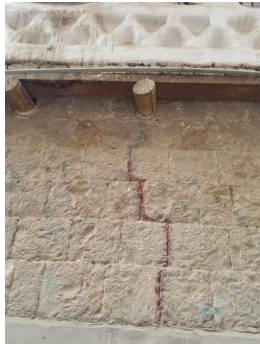
شكل (11)، ظهور تشققات في الجدران البنائية الحجرية نتيجة عدم وضع طبقة المرايب الخشبية تحت الجذوع الخشبية الحاملة للجدران المعلقة والمنبئية بالباجور (الأجر)
