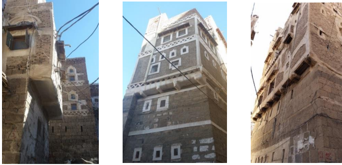
شكل (13): كلما زاد عدد الطوابق المعلقة تقل مسافة بروز الجدران الحاملة المعلقة
