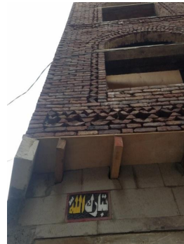
شكل (11)، ظهور تشققات في الجدران البنائية الحجرية نتيجة عدم وضع طبقة المرايب الخشبية تحت الجذوع الخشبية الحاملة للجدران المعلقة والمنبئية بالباجور (الأجر)
