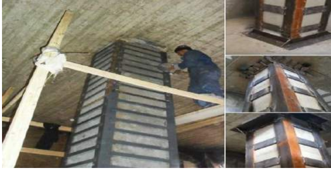
شكل (1): صورة لأعمدة خرسانية مقواة بهياكل فولاذية
