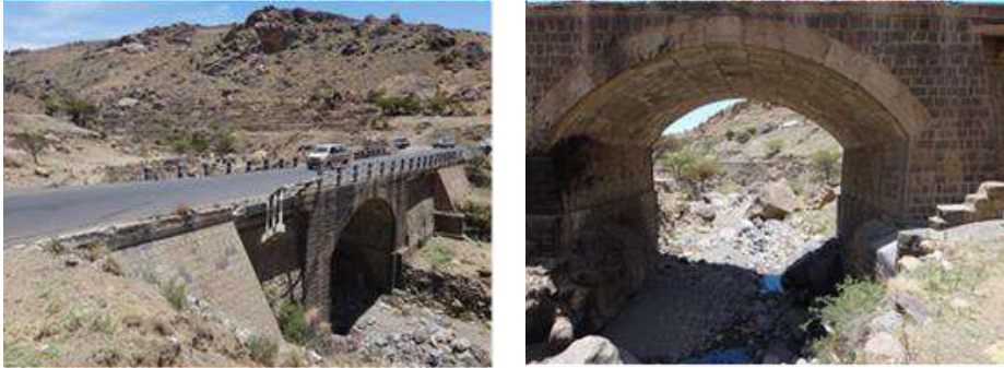
Figure 3: Wadi Osfarah Bridge
